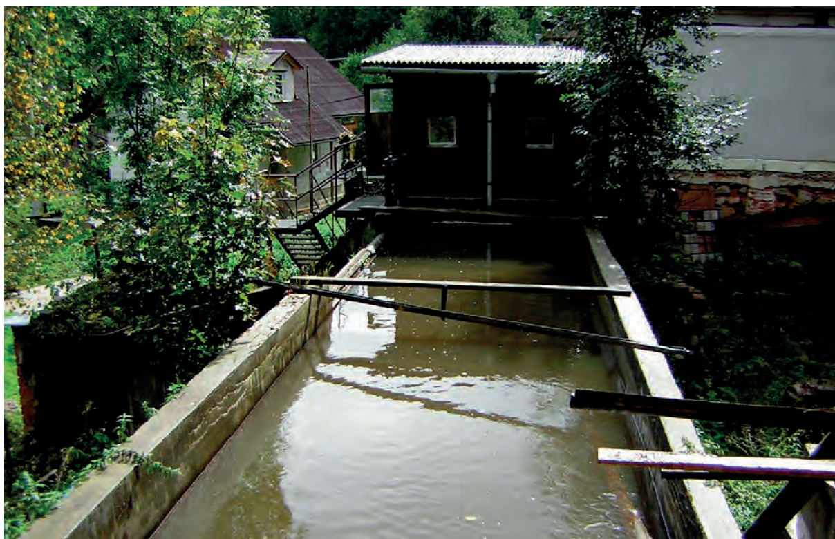
Obr. 13. Beztlakový přivaděč ( https://dspace.vutbr.cz/ )
