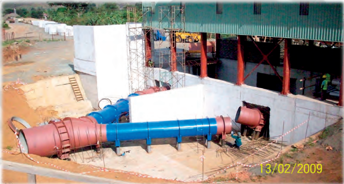
Montáž kalhotového kusu přívodního potrubí
