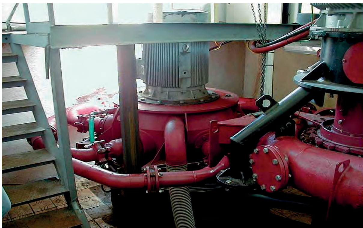
Obr. 26. Vertikální Peltonova turbína
